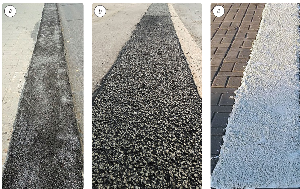
Рис. 7. Внешний вид полос противоскольжения (ППС): a – на остановочном пункте «Белавтогаз»; b – на остановочном пункте «Холмогорская»; c – полоса безопасности перед пешеходным переходом
